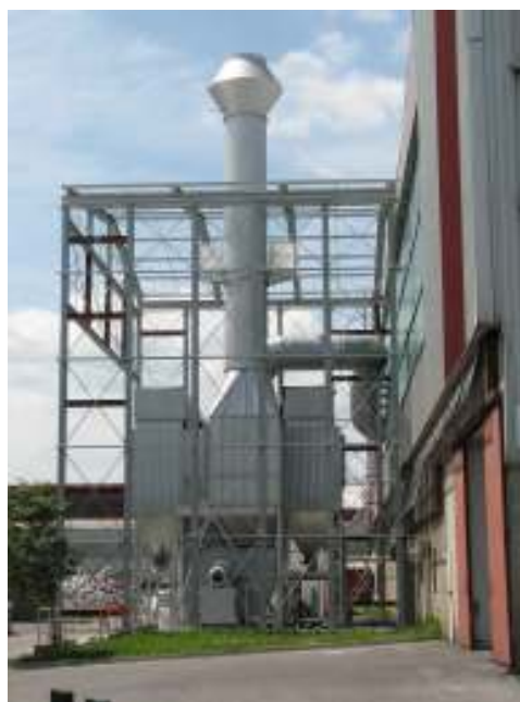
Čistilna naprava v obratu gnetnih zlitin
